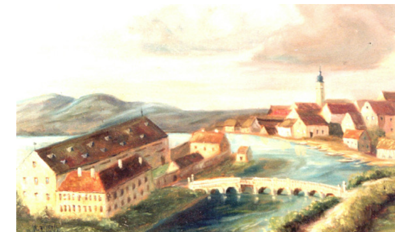
Blick auf die Fischhofbrücke, erbaut 1748 - 1750 von Baumeister Philippo Muffone
